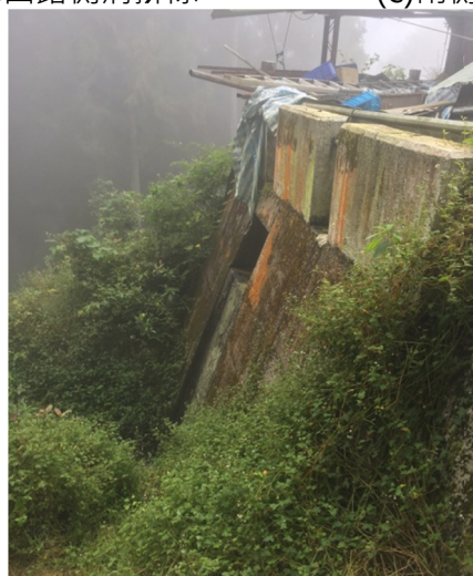
(e) 排水溝出水口與擋牆連接處(南側)
