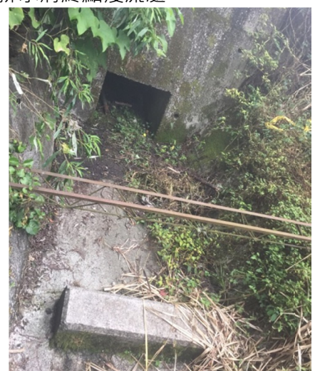
(f) 擋牆下方出水口及齒墩現況(北側)
