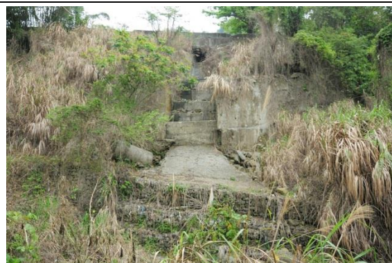
既有排水工程及石籠護岸
