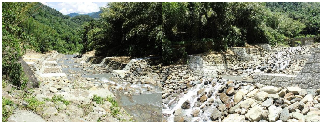
由上游既有版橋看工區全景
