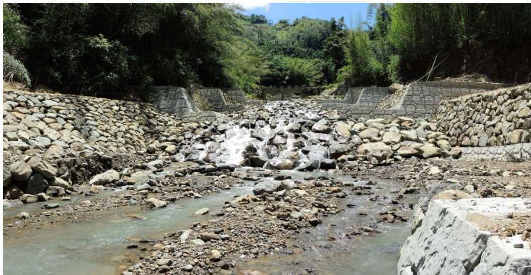
上游部份施工後現況，固床工及護岸施作開挖範圍小
