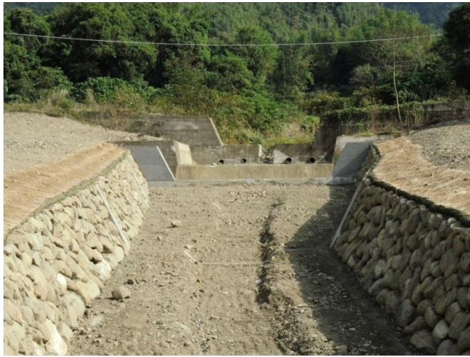
圖 1 施工完成時在溪床營造深槽區
