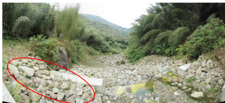
圖 2 既有版橋下游左側，前期工程之砌石緩坡
