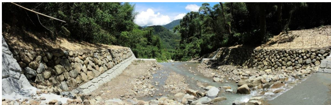
下游部份施工後現況
