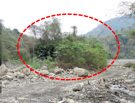
下游 85 林班工程開口壩右側的小片闊葉林
