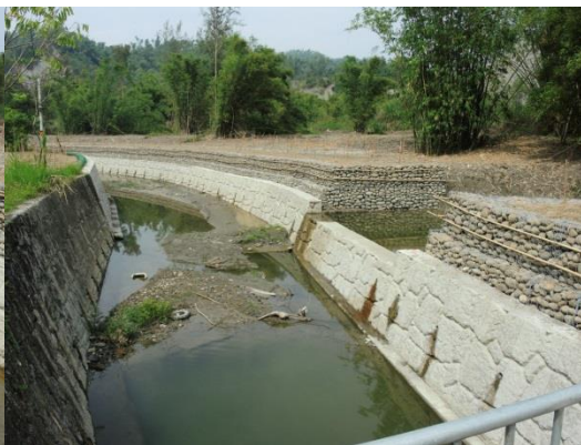
連接上游版橋處與溪溝匯流口
