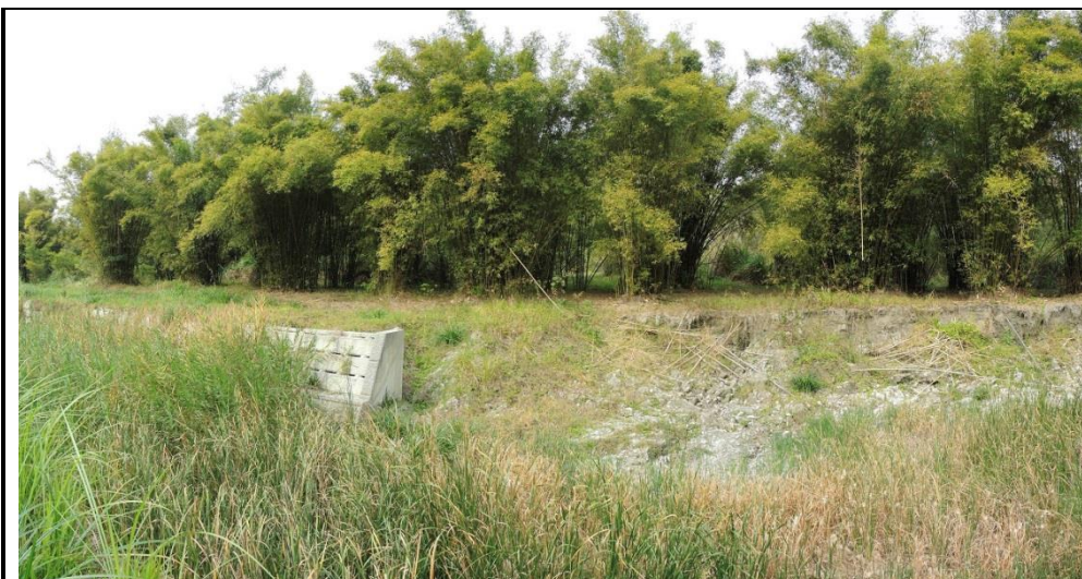
本期工程下游連接既有護岸工程
