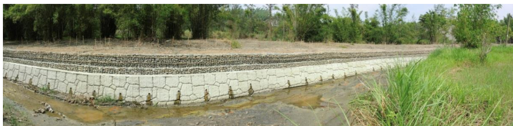
施工便道設置於右岸
