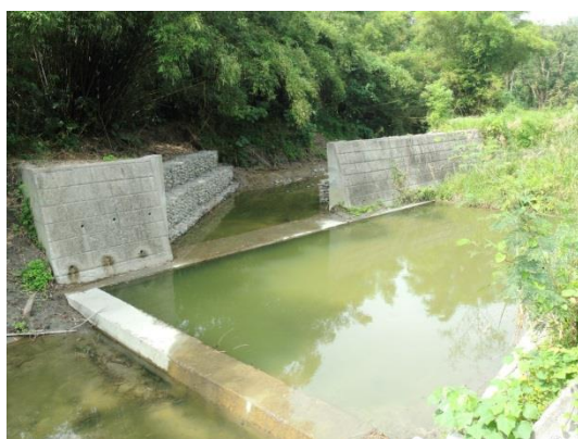
支流新設石籠護岸
