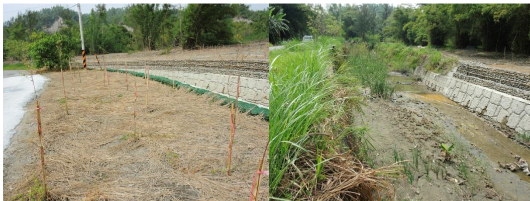
兩岸工程後裸露地栽植台灣欒苗木
