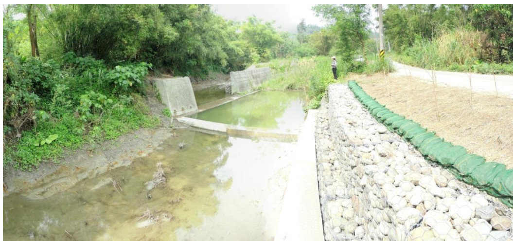
主流左岸新設石籠護岸 工區 1 施工中(2015/6/4)
