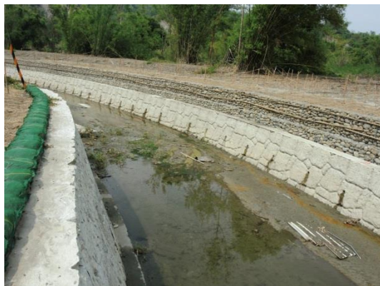
水量較大，流速緩快 工區 2 (完工後，2015/10/19)
